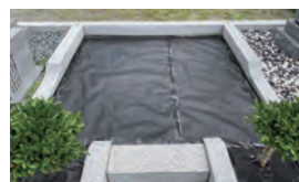
防草シート敷き込み
