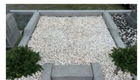
防草シートの上から玉砂利を敷いて完成
